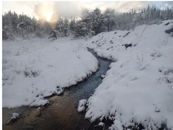
Vannvei som fører nedover mot kulverten vist på bildet til venstre. Deponiområdet ligger til høyre på bildet, og synes som en fylling på siden av bekken.
