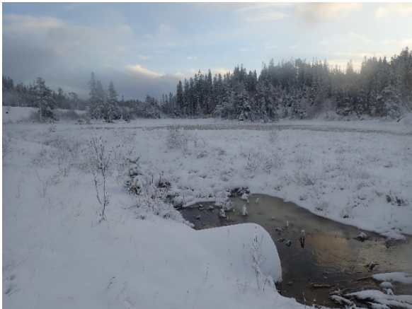
Området ved Sagdammen, med kulvert som fører under fv720
