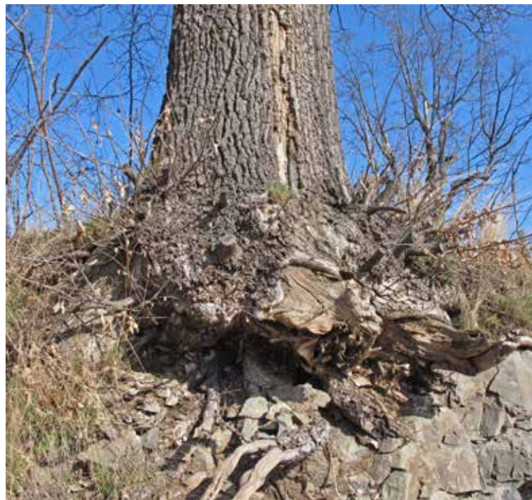
En eik stående tett ved en veiskjæring i Bærum kommune har mistet alle røttene på den ene siden, noe som fører til et ustabil tre og et forkortet livsløp. Foto: Stefan Olberg.
