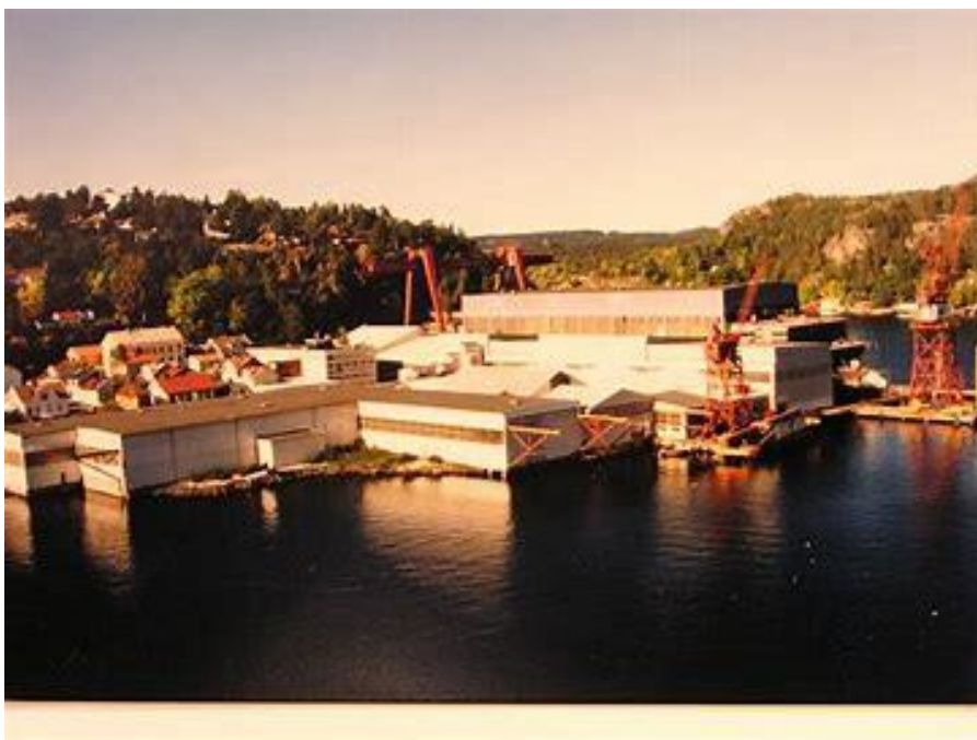
Figur 5: Flyfoto Tangen Verft, Stilnestangen – Kragerø 1990-tallet
