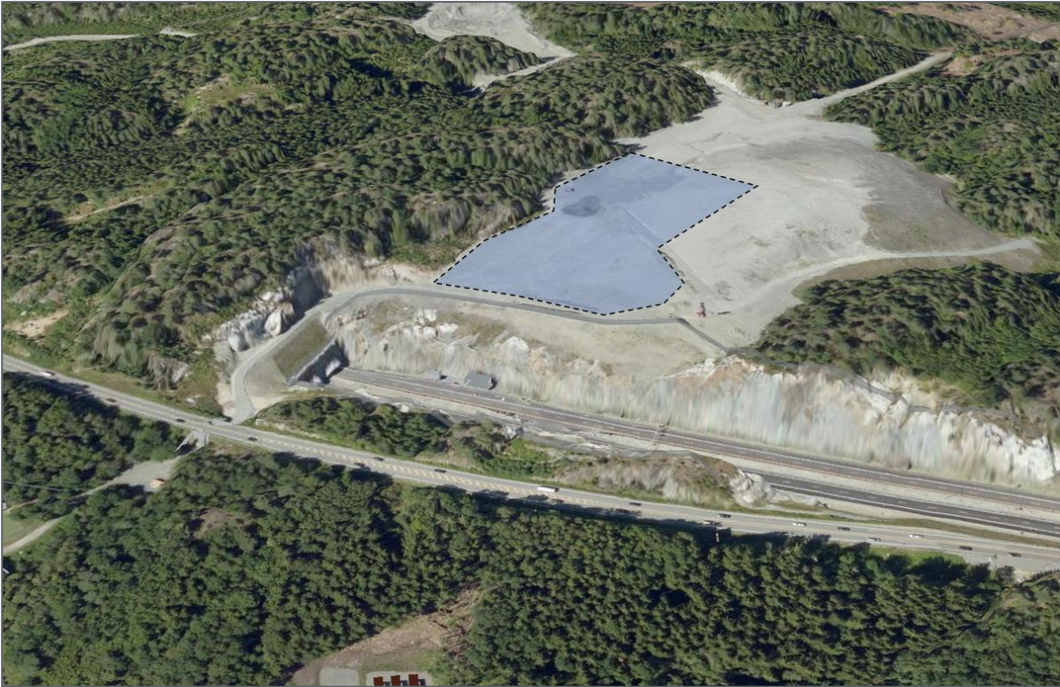
Figur 3. Markering av område for det planlagte deponiet. Bildet viser arbeidet med massedeponiet til E18- Bommestad - Sky. Massedeponiet er per dags dato avsluttet med markdekke. Kilde: Kommune kart 3-D visning.
