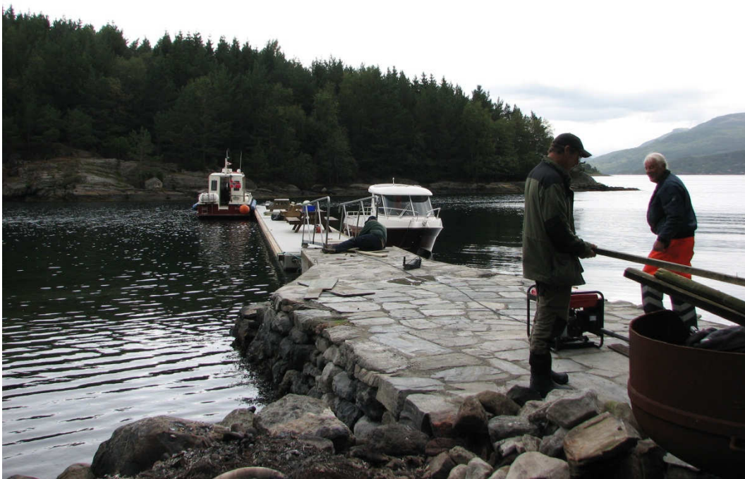
Dugnadsarbeid i forbindelse med ny flytebrygge på Herøy
