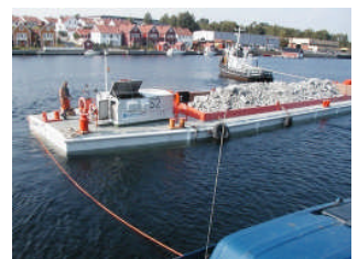
Erosjonssikring i Skjenselva.
