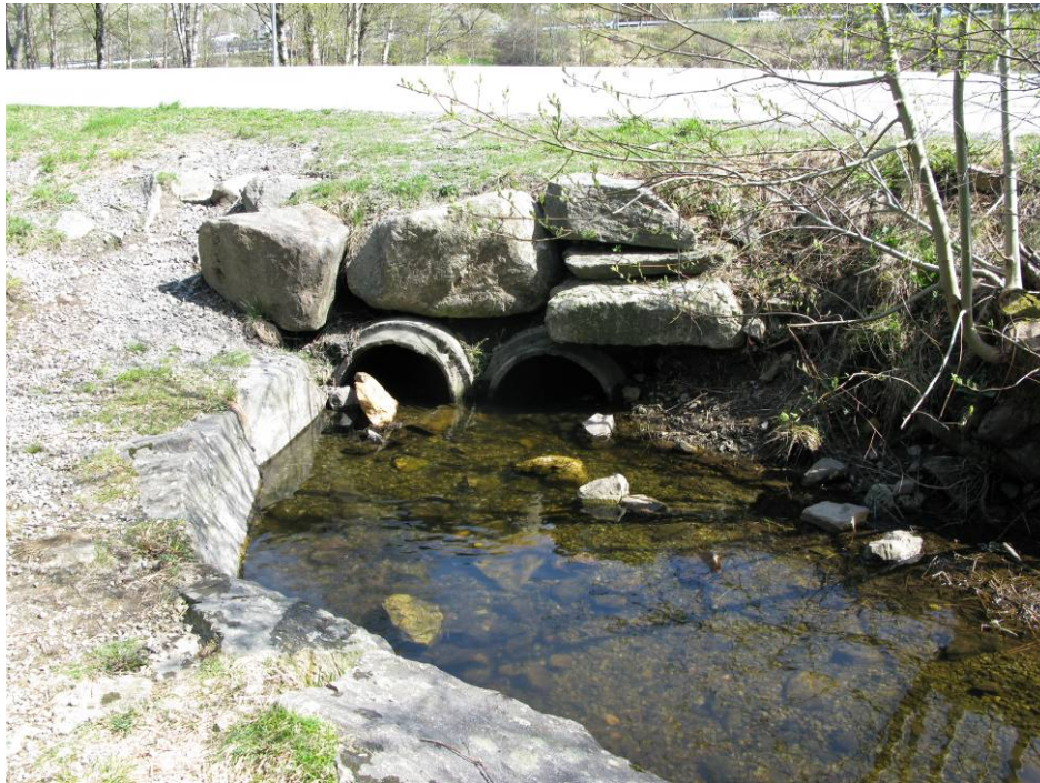
Figur 4.1. Utløpet fra Førrestjørna går i rør under veien
