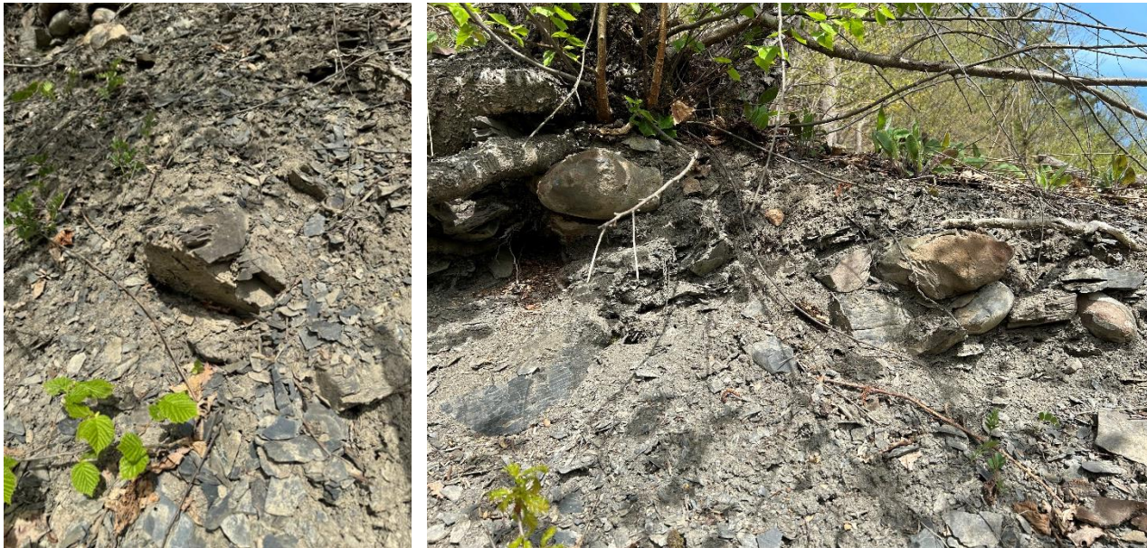
Figur 2-3: P1, P2 og P3 ble samlet inn utenfor fjellhallene ved det framtidige påhugget.
