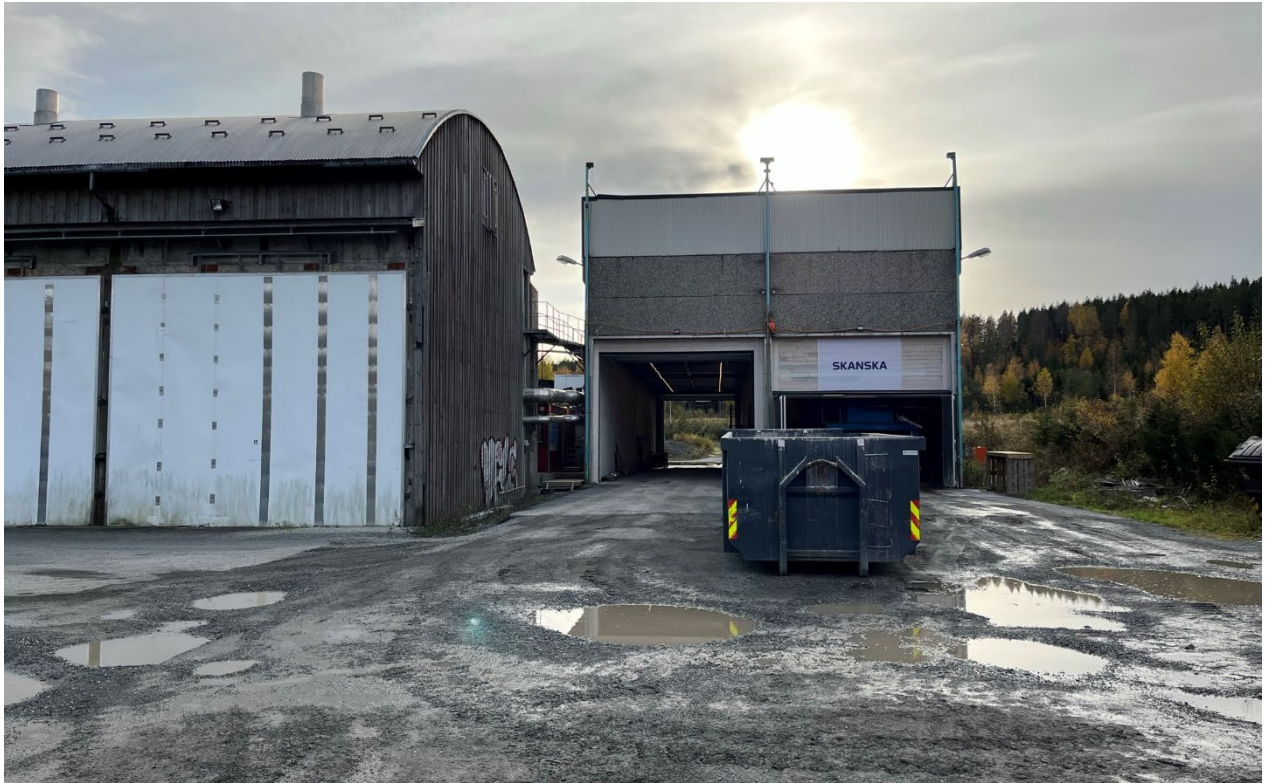
Figur 9 Bygningen som huser anlegget sett forfra. Venstre side (åpne) er gjennomkjøringsstedet ved levering av slam. Slammet levers inne i bygget og direkte i kum/kontainer. Selve filterpressen er lokalisert i den høyre delen (der det står skanska).
