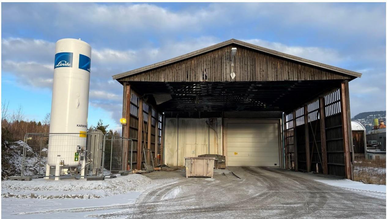
Figur 10 Baksiden av bygget som huser slambehandlingsanlegget. Levering av slam skjer gjennom porten til høyre. Tanken til venstre på bildet er anleggets CO 2 -tank for pH justering.
