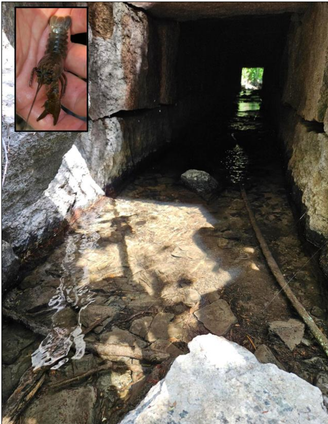
Figur 5-17. Vannføring gjennom kulvert i Padderudbekken og ferskvannskreps observert på befaring 22.06.2023.
