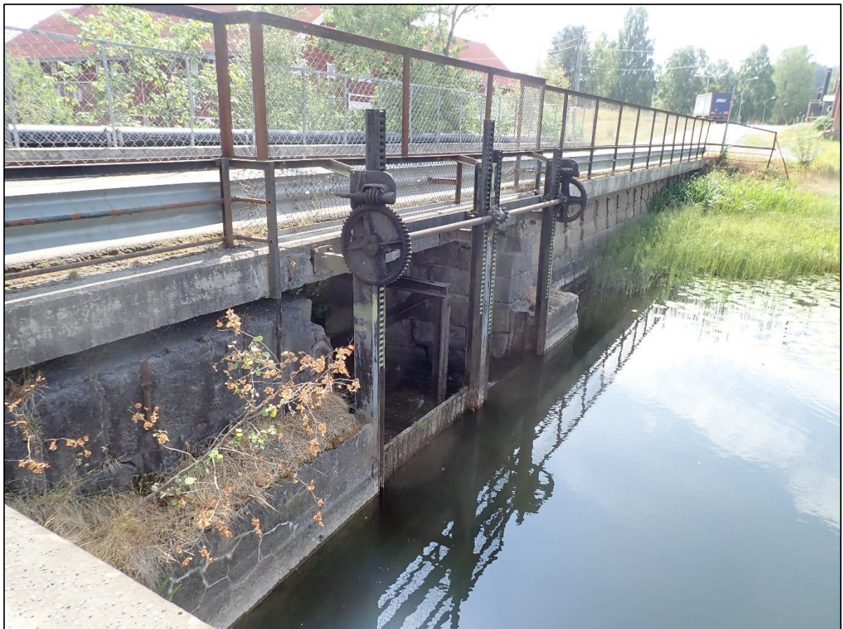
Figur 1-1. Bilde av dammen på oppstrøms side.
