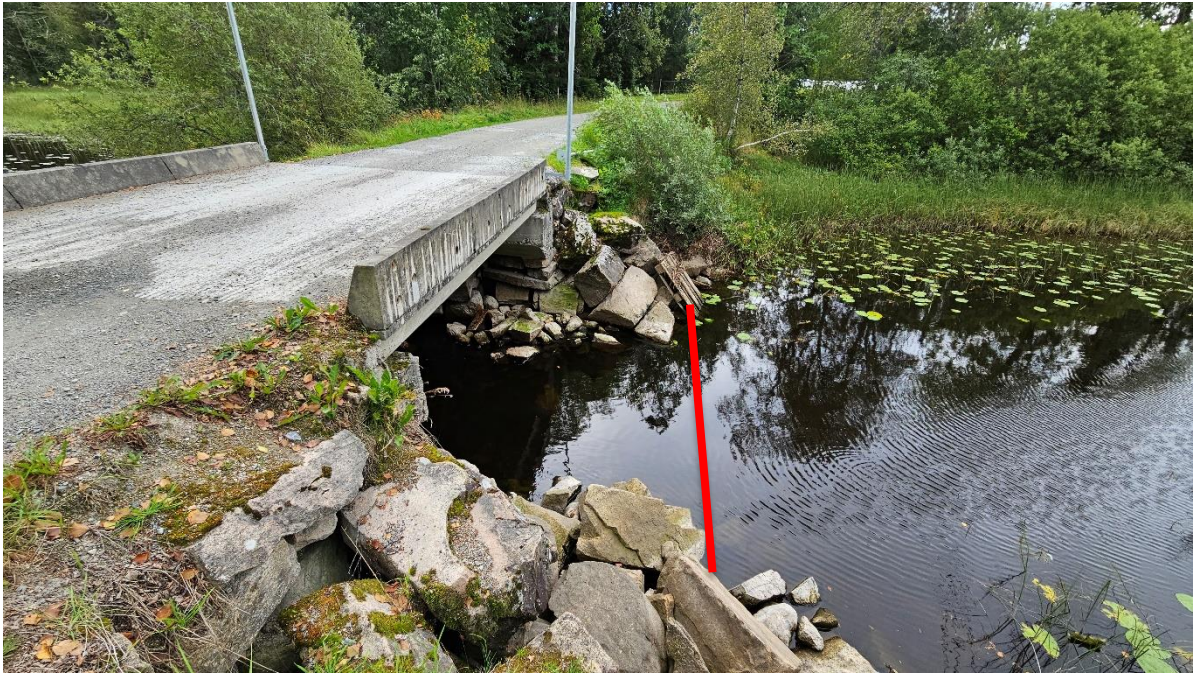
Figur 3 Plassering av terskel foran bro.
