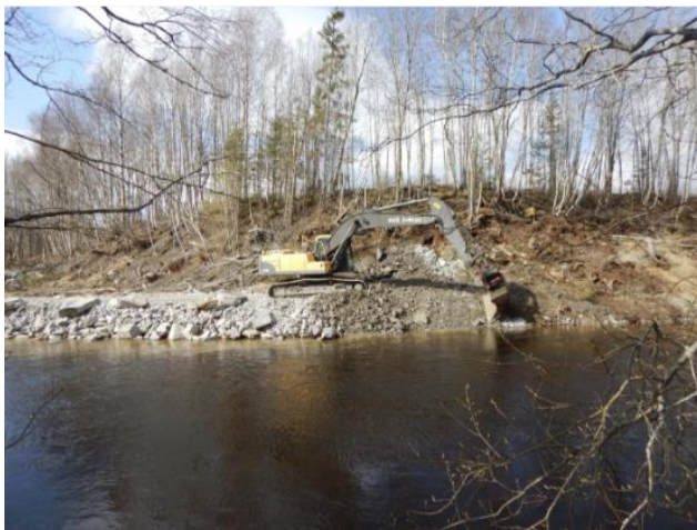
Figur 9. Eksempelbilde omstrukturering av elveskråning. Kilde: NVEs modul F2.201
