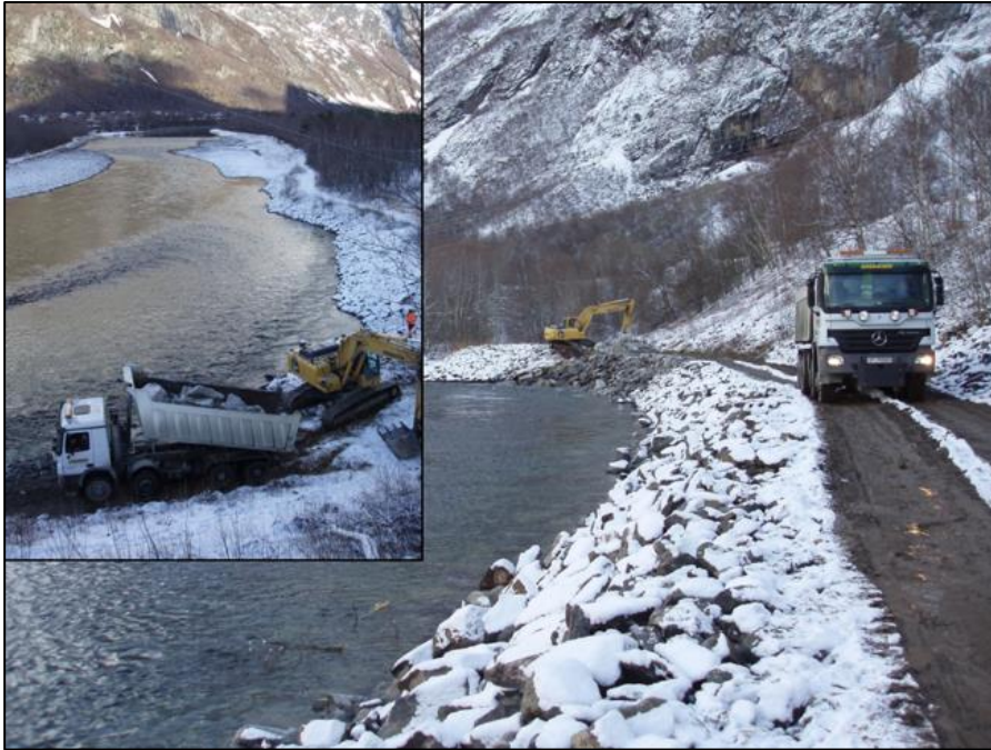
Figur 14 – Sålen i sikringen fungerer som anleggsvei og mottak av masser. Anleggsveien fjernes etter hvert som tiltaket ferdigstilles (/23/).
