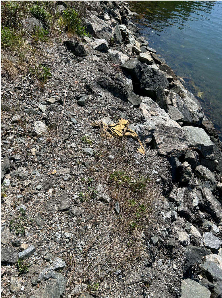
Figur 3-2. Bilde av fyllmasser med en del asfalt og noe avfall.
