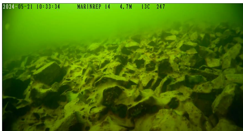
Figur 3-6. ROV-bilde fra transekt Spro3 av molofoten. Steinutfyllingen er dekket av lurv/slam. Det ble observert noen få yngel/småfisk i dette området, men svært lite aktivitet.
