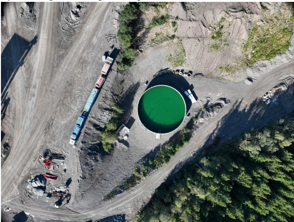
Figur 6 Flyfoto av eksisterende vannmagasin i pukkverket.
