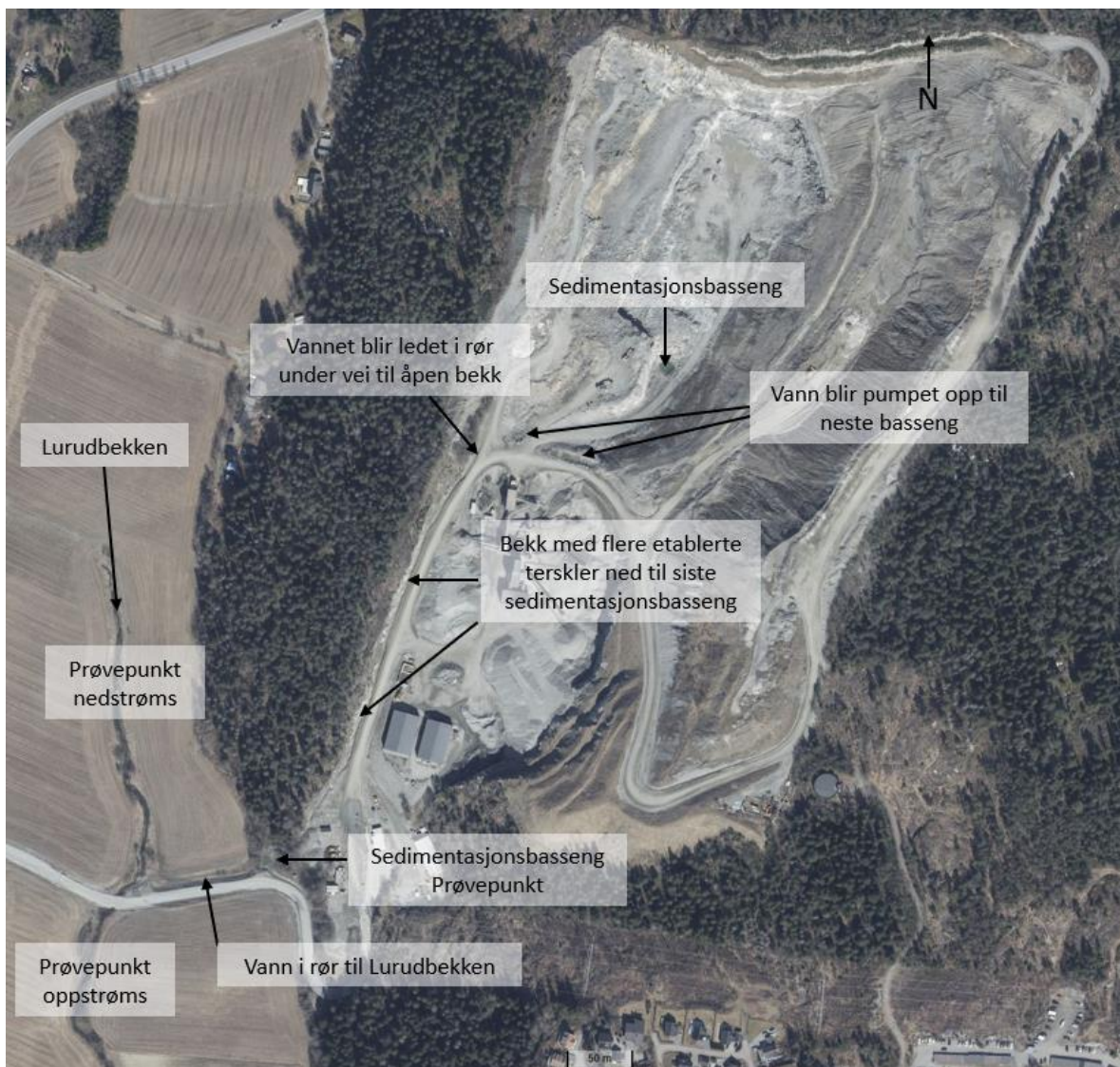
Figur 1: Plassering av prøvepunktene for vannovervåking for anlegget (norgeskart.no).
