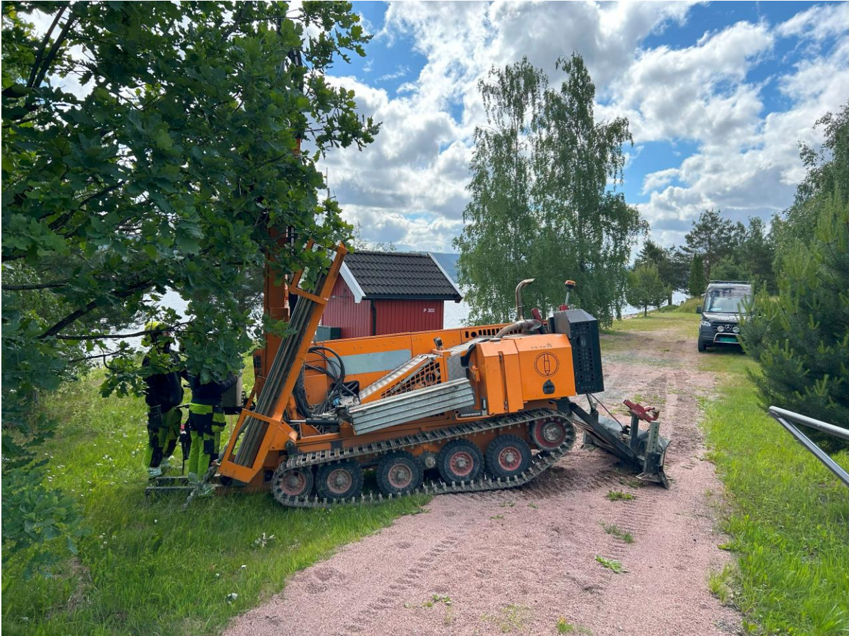
Figur 4-2: Bilde som viser området ved Hella. Området er dekket av gress og en tilkomstvei til badeområdet. Det står en eldre kum med overbygg ved Hella som skal utvides. Bilde: Sweco
