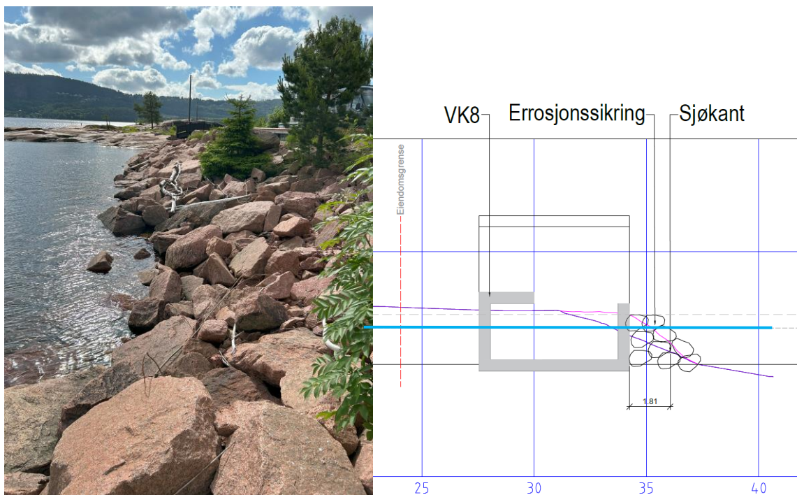
Figur 2-10: til venstre: bilde av vannkanten ved Blindeskjæra slik den ser ut i dag. Det ligger store blokksteiner langs med vannkanten som må flyttes og tilbakeføres ifm. tiltaket. Til høyre; utklipp av vedlegg 5 som viser snittprofil at ny erosjonssikring. Kilde: Sweco
