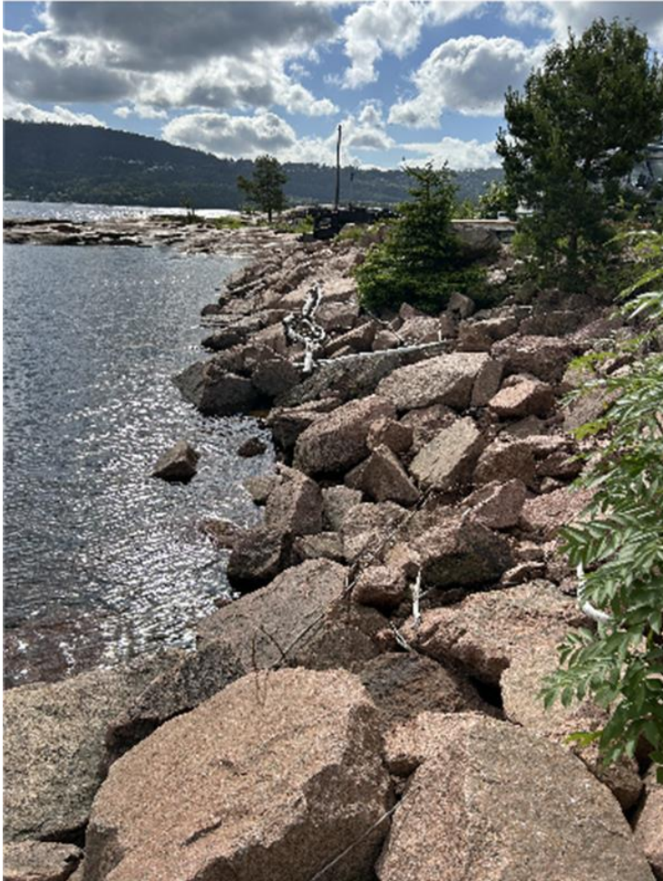
FIGUR 2 - EKSISTERENDE STEINFYLLING I SJØ VED BLINDESKJÆRA
