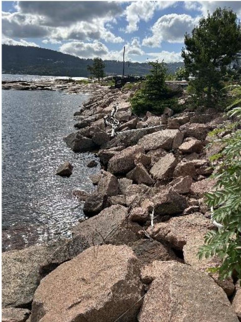
Figur 5 - Eksisterende steinfylling i sjø ved Blindeskjæra
