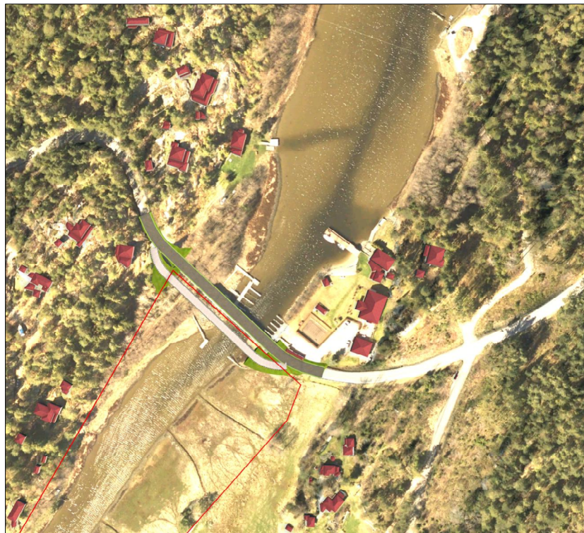
Figur 1-7: Illustrasjonen (fra "Silingsrapport Grimsøy bru") viser valgt alternativ 1A med permanent bru/vei (mørk grå) i samme trasé som eksisterende. Midlertidig bru (lys grå) syd for permanent bru. Rød linje indikerer opprinnelig reservatgrense, før flytting.
