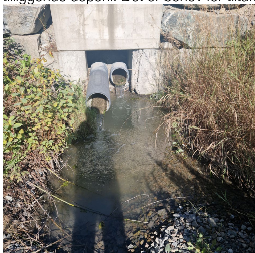
Figur 7 venstre: Bilde av utslippspunktet fra sedimentasjonsbassenget, dette er starten på en av sidegrenene til Tokerudbekken.
