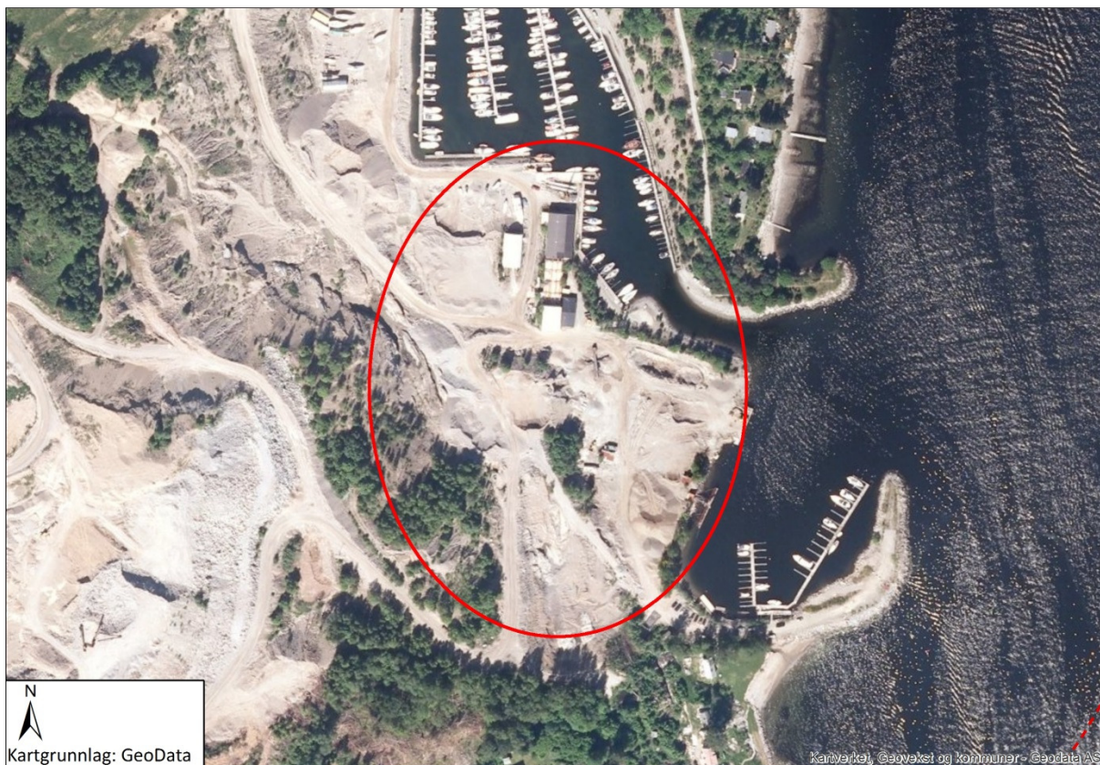
Figur 2. Boligrigg ved sandtaket på Verpen under byggetrinn 1 av Oslofjordforbindelsen.
