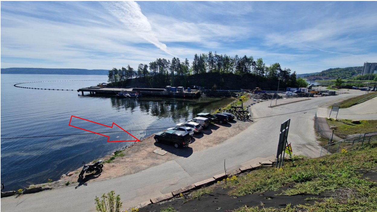
Figur 2-5: Bilde over hvor landtaket ved VEAS skal etableres. Bilde ser mot sør. Kilde: Sweco
