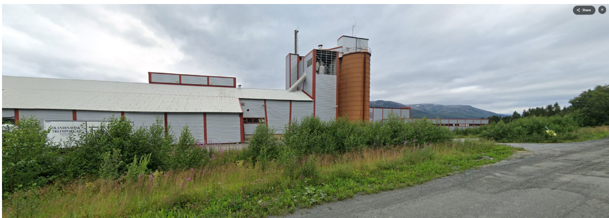
Figur 5 Holandsvika bionæringspark. Kilde: Google Maps.
