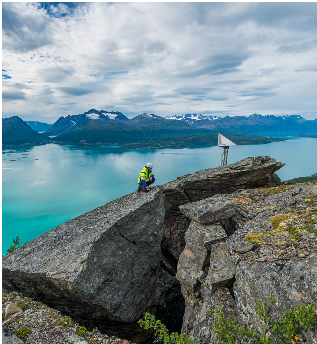
Bernt Lyngstad fra NVE studerer en av mange sprekker på det ustabile fjellpartiet Jettan i Nordnesfjellet i Kåfjord kommune. På bildet ser vi også en satelitreflektor som måler bevegelse i fjellet. Lyngseidet i bakkant til venstre. FOTO: Ørjan Bertelsen.
