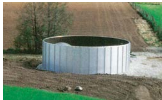
Tank med stålplateveggar og innvendig armert duk. Tanken kan demonterast og flyttast etter måten enkelt. Den vert levert i høgder på 4 og 3 meter og kan utstyrt med dekke for å halde nedbøren unna. Foto: «Hansen Protection»
