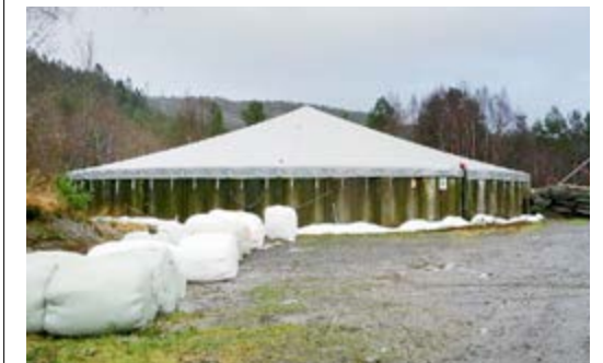
Rund betongkum er den mest brukte lagertypen for storfe-gjødsel i nyare bygg. Her ei utgåve forsynt med pyramidetak av armert duk som ligg over ei støtte plassert midt i tanken og spent nedover sidene. Denne takkonstruksjonen kan også ettermonterast og er utstyrt med luke for pumping, omrøring og tilkomst. Foto: Jorunn Giskemo
