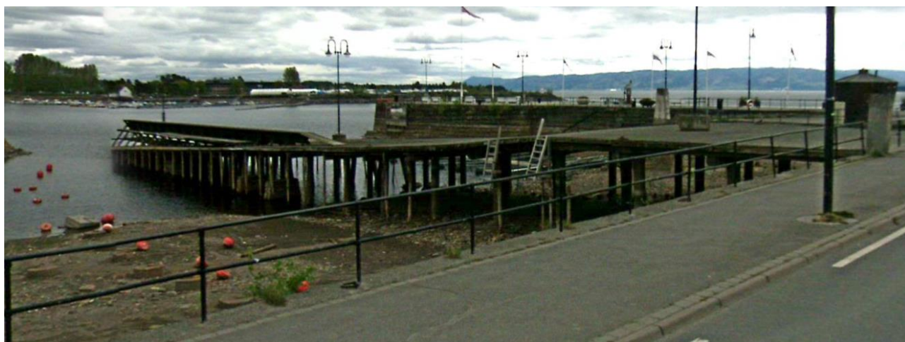
Figur 8: Bilde som viser pelebrygge som er planlagt revet som del av etappe 1b. Kilde: www.google.no/maps .
