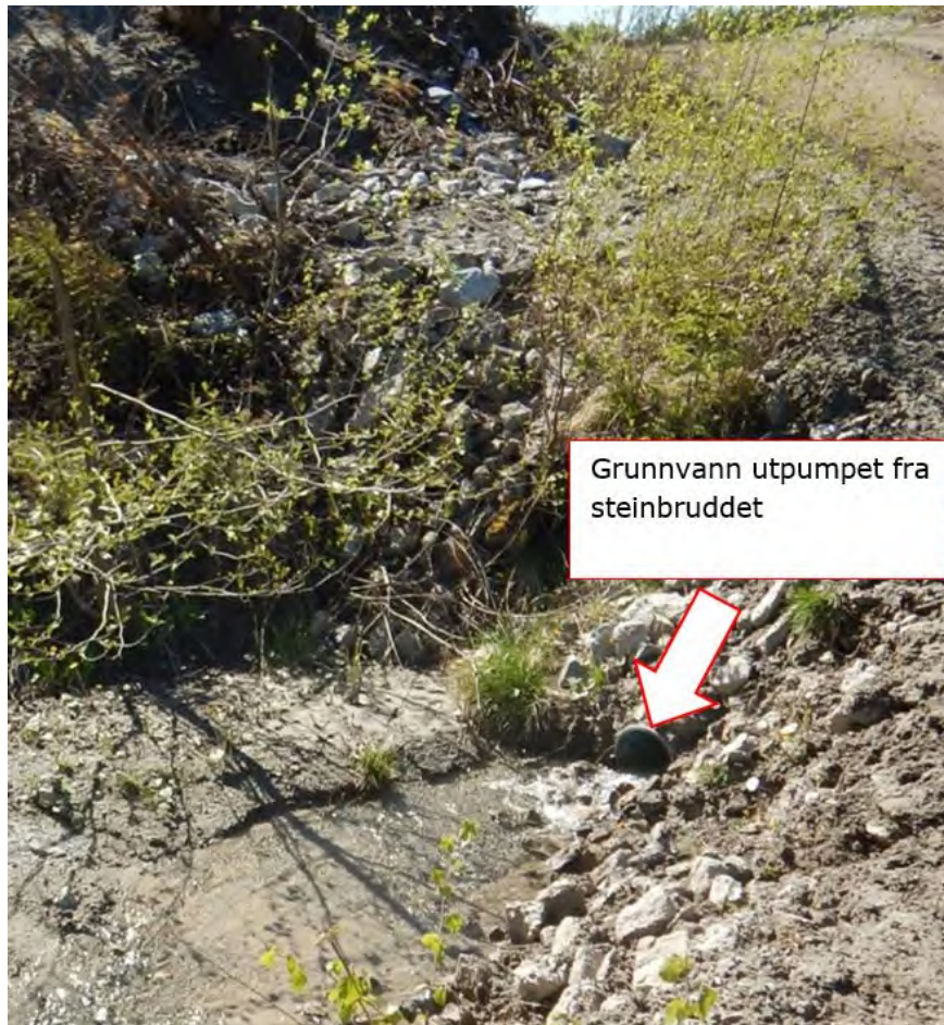
Figur 6. Bilde av grunnvannsprøvestasjon GV2 prøvetatt i mai 2017. Grunnvann ble pumpet ut fra steinbruddet og sluppet til terrenget nord for steinbruddet. Like etter prøverunden i mai ble det tatt i bruk en ny brønn for utpumping av grunnvann fra steinbruddet. Vann fra denne brønnen ble tidligere sluppet til terreng ved steinbruddet.
