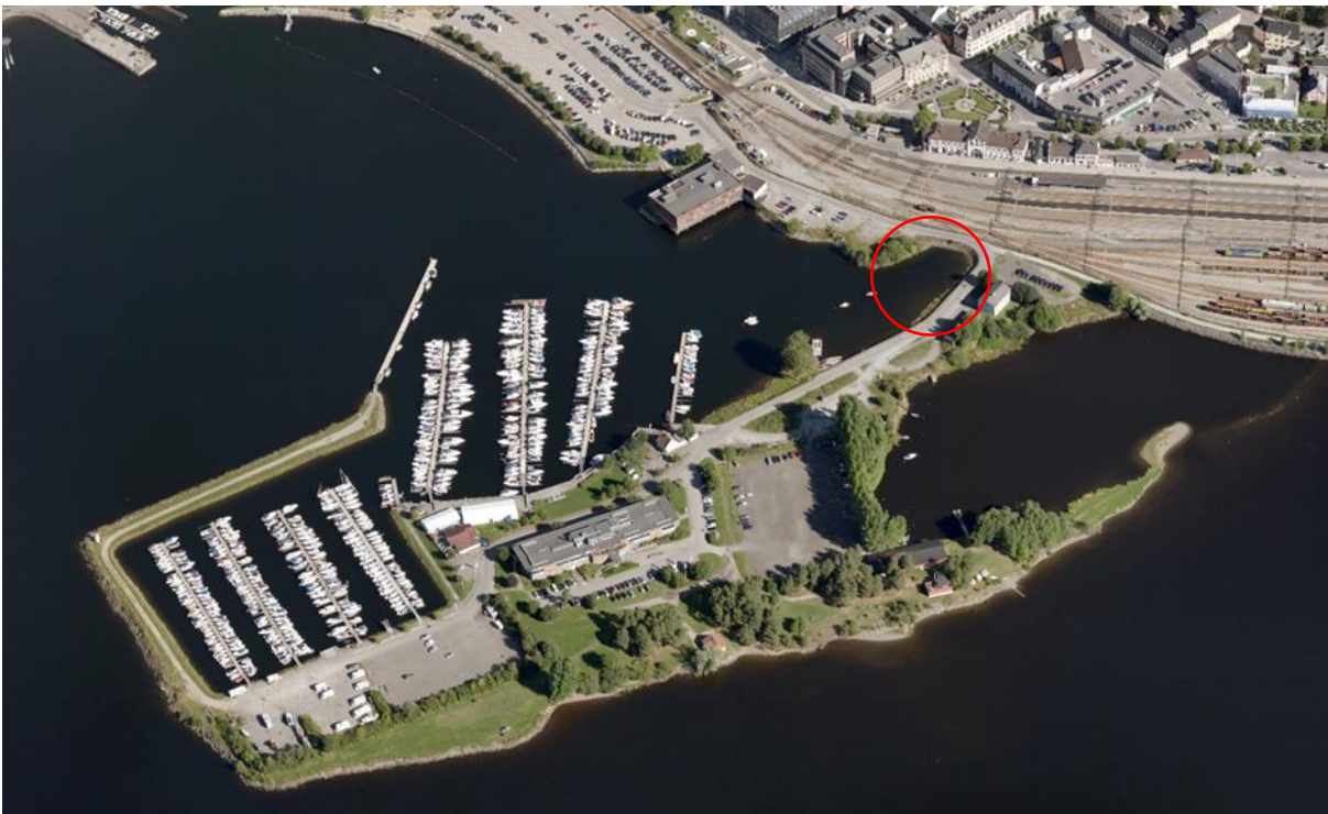
Figur 8. Tjuvholmen ligger sentralt i strandsonen; en grønn halvøy i forlengelse av sentrumsstrukturen i Hamar. Tiltaksområdet (rød sirkel) for denne utredningen ligger på båthavnsiden langs innkjøringen til Tjuvholmen. Kilde: Hamar kommunes storymap om Tjuvholmen, Tjuvholmen (arcgis.com).
