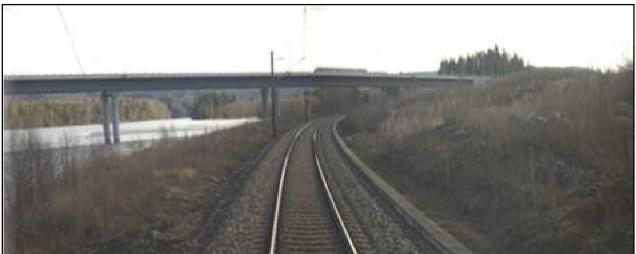
Figur 1.4 Foto som viser eksisterende jernbanelinje og E16/Gulli bru, sett fra vest i retning mot Kongsvinger.
