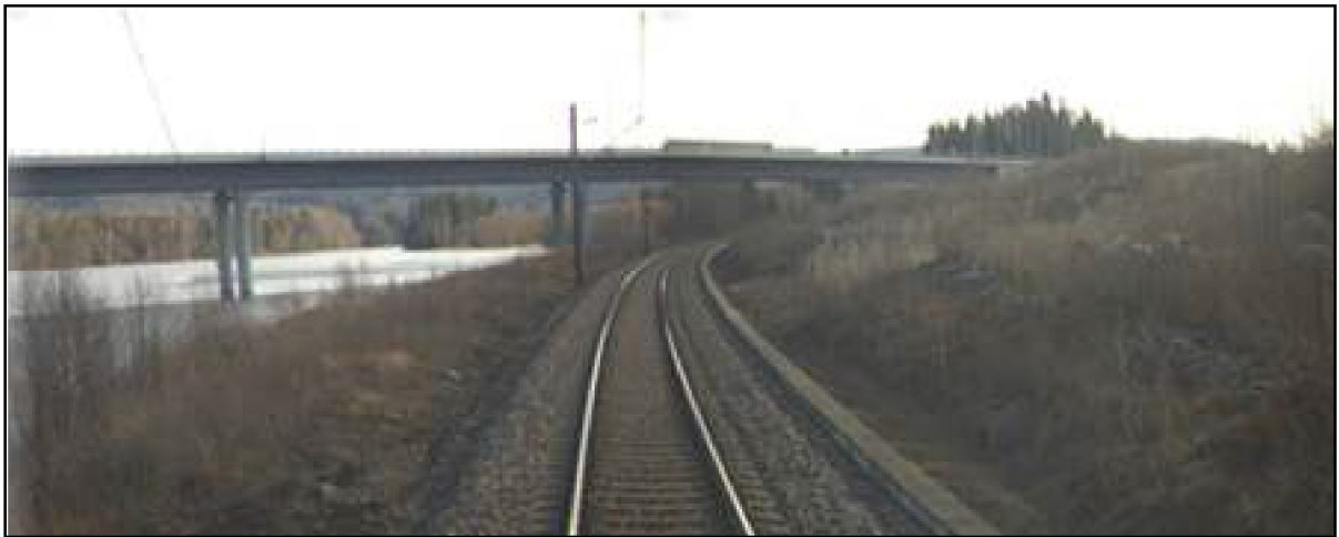
Figur 4.4 Gulli bru sett fra vest mot øst.
