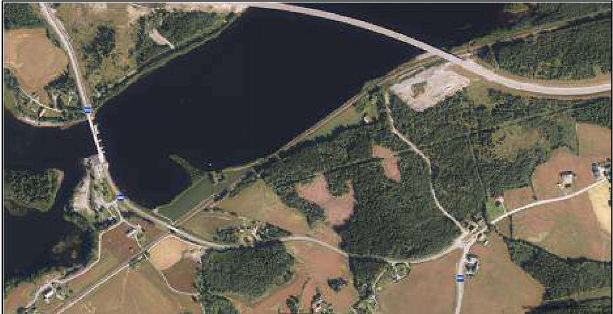
Figur 1.3: Flyfoto som viser plan- og influensområdet. Kraftverksvegen krysser over Glomma til venstre i bildet, E16 og Gulli bru til høyre i bildet. Eksisterende jernbanelinje langs Glomma sees som en linje på fotoet.
