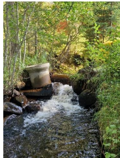
Bilde 39: Terskel i bekken, om lag 30 meter oppstrøms kulverten. Foto: Thomas Ustvett
