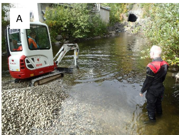
Figur 26: A: Bilde av utlegg av gytegrus i 20.09.2018, hvor det ble brukt en liten gravemaskin for å fordele ut gytegrusen. Foto: Odd Henning Stuen. Tunnelutløpet fra kraftverkstunnelen kan sees i bakgrunnen. B: Bilde (tatt 20.09.2018) av gytegrusen som ble lagt ut. Foto: Ola Hegge.
