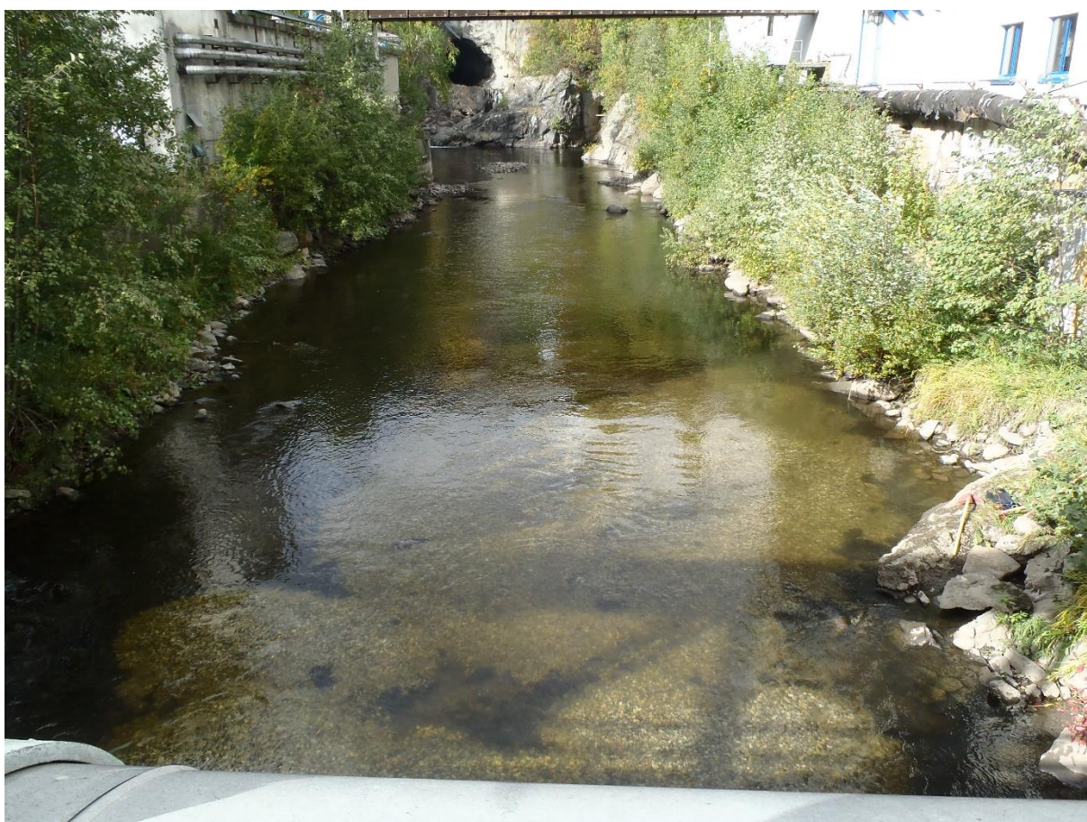
Figur 27: Bilde tatt 20.09.2018 etter utlegget av og fordeling av gytegrus, nedstrøms utløpet fra kraftverkstunnelen tilhørende Brufoss kraftverk. Tunnelutløpet fra kraftverkstunnelen kan sees i bakgrunnen. Foto: Odd Henning Stuen.
