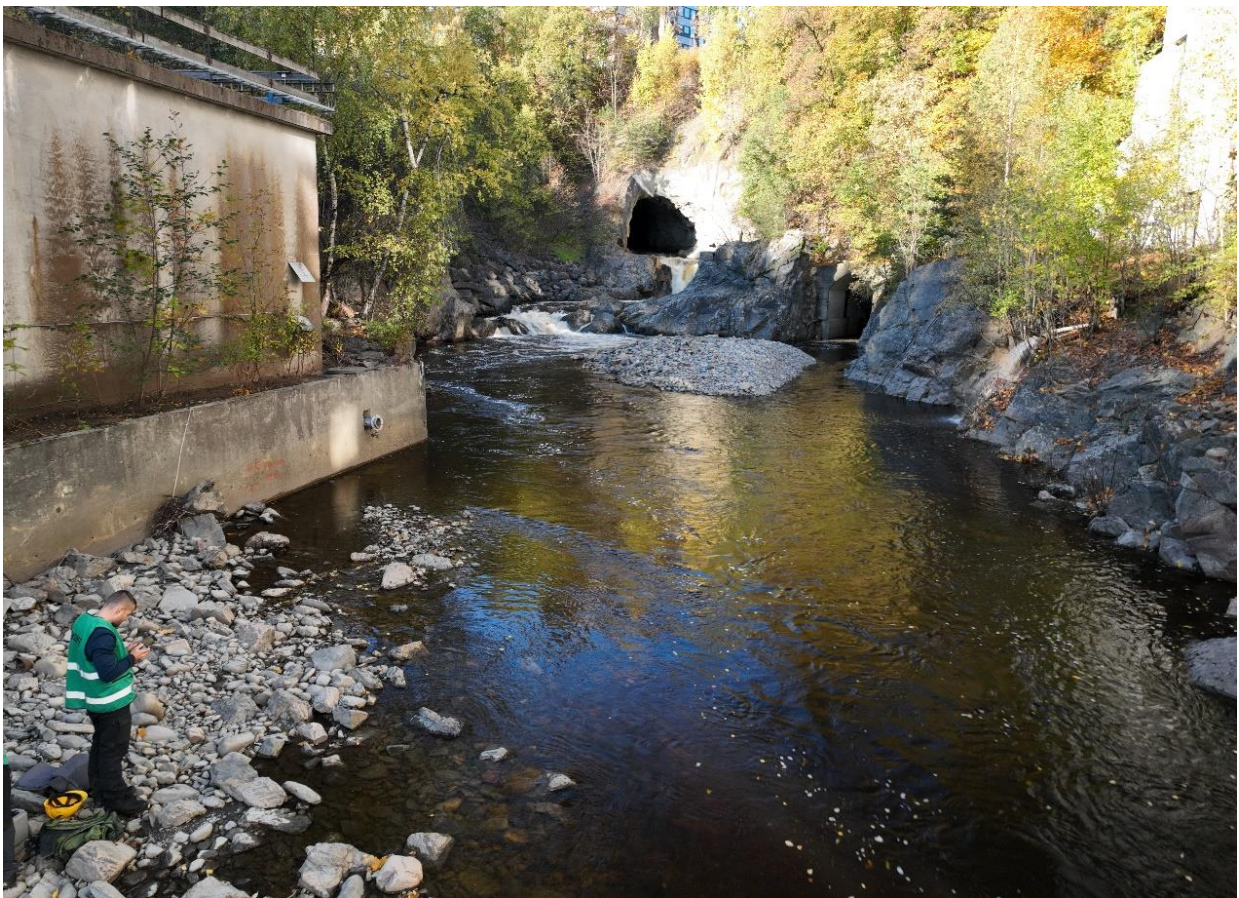
Figur 28: Bilde tatt med drone 12.10.2023 nedstrøms utløpet fra kraftverkstunnelen tilhørende Brufoss kraftverk. Tunnelutløpet fra kraftverkstunnelen kan sees i bakgrunnen. Foto: Thor Bjørn Thorkildsen.
