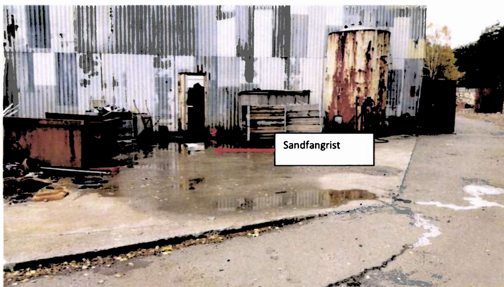
Støpt plate ca.200 m 2 som drenerer til oljeutskiller
