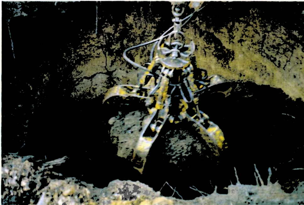
Figur 3: Uttak av masser i sjaktpunkt 1.
