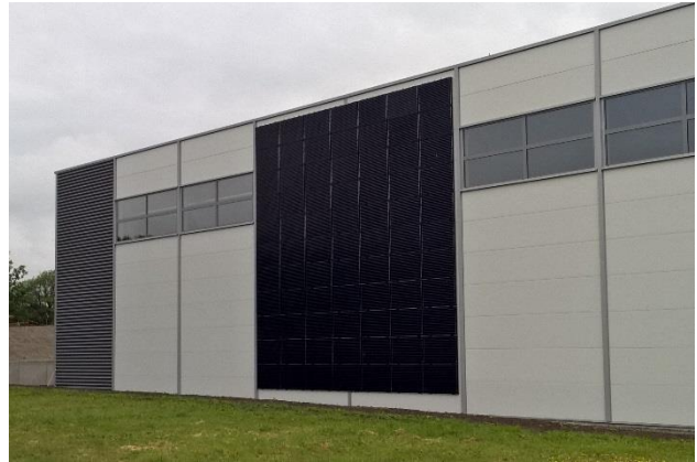
Figur 19. Eksempel solcelleanlegg fasade. Haldenterminalen. Kilde: FUSen.
