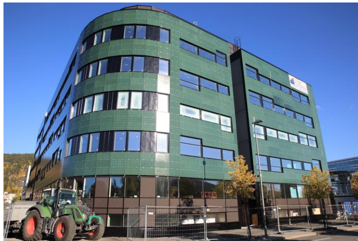
Figur 20. Eksempel på bygningsintegreert solcellefassade med grønne solcellemoduler. Kilde: Fusen.
