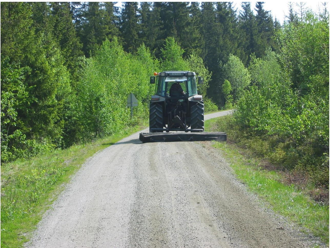
Årlig vedlikehold er viktig for å ivareta investeringene i skogsveger. Drammenslådden er et egnet redskap. Foto: Berit Sanness
