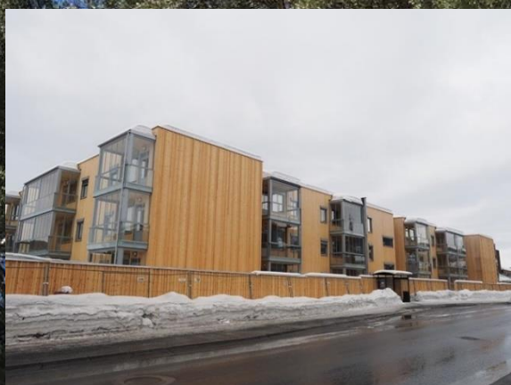
Gartenerhagen omsorgsleiligheter på Lillehammer. Bygd i massivtre og med passivhusstandard. Foto: Treindustrien.
