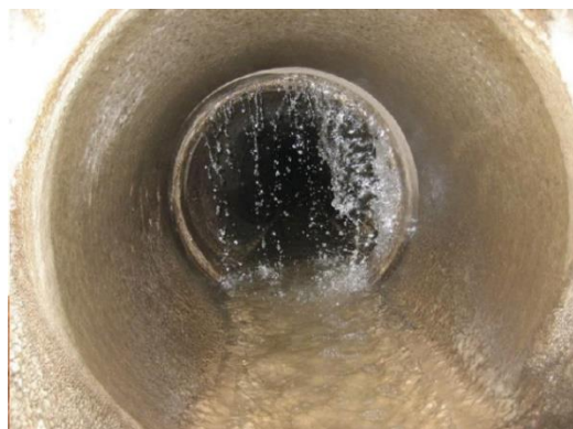
Figur 5 Eksempel på innlekking av fremmedvann
