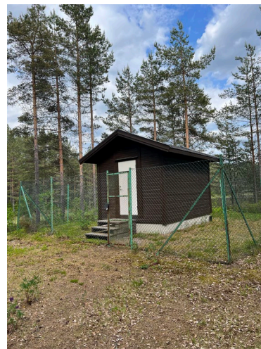
Figur 6. 1 av 2 Brønnpumpehus, bildet er tatt ved befaring.
