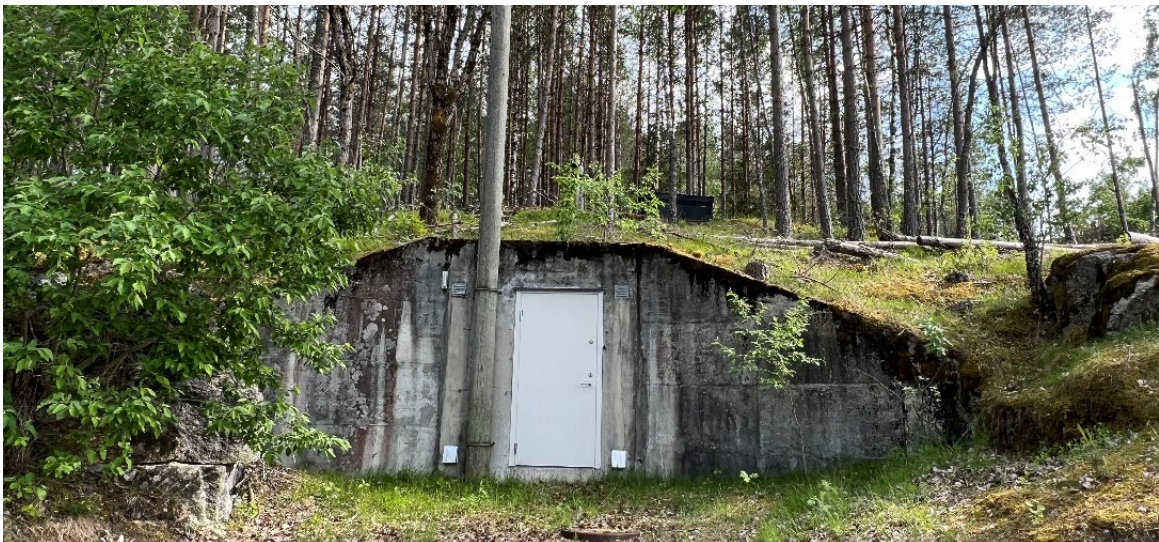
Figur 9. Høydebassenget til den kommunale vannforsyningen.
