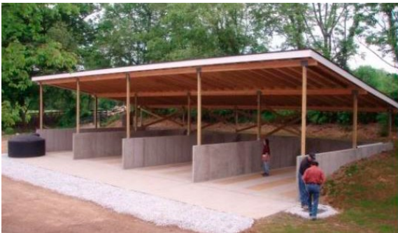
Binge for kompostering av gjødsel. Foto: Gry Løberg
