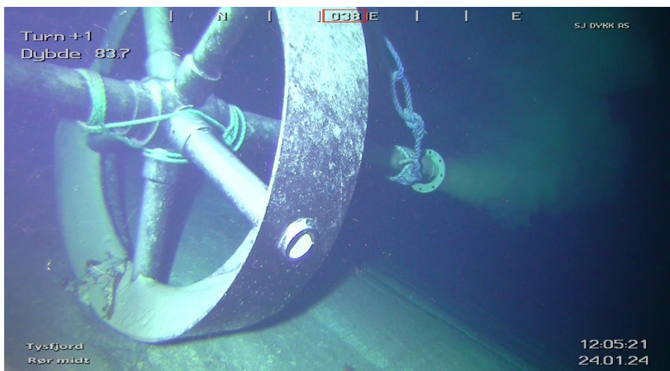
Figur 4-18 Utslippsrør på ca. 80 m dyp. Mye hvitt partikkelslam i området.
