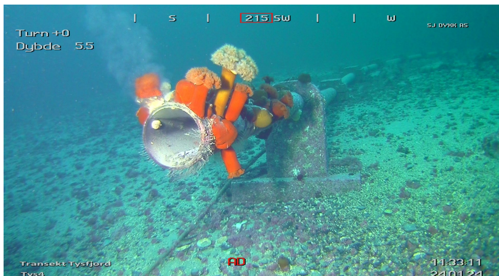
Figur 4-12 Tys 4, 6 m, I planområde, utslippsrør (kommunalt overløp) med sjønnellik og annen påvekst, sandbunn og lite rugl.
