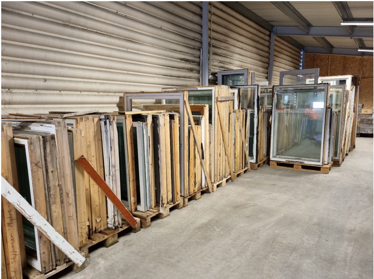
Figur 1: Manglende merking på lagringsplass for klorparafinholdige vinduer.
