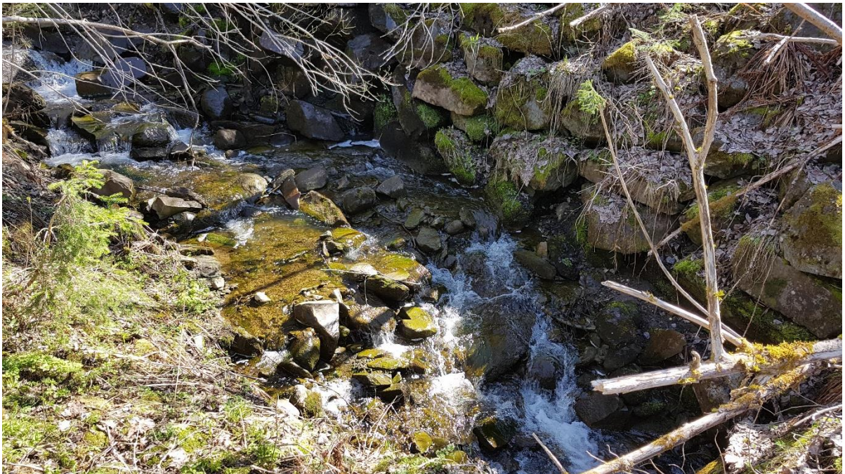
Figur 24. Oppstrøms innløp til kulvert ved planområdet. Tørrmur/stablet blokker på sidene.
