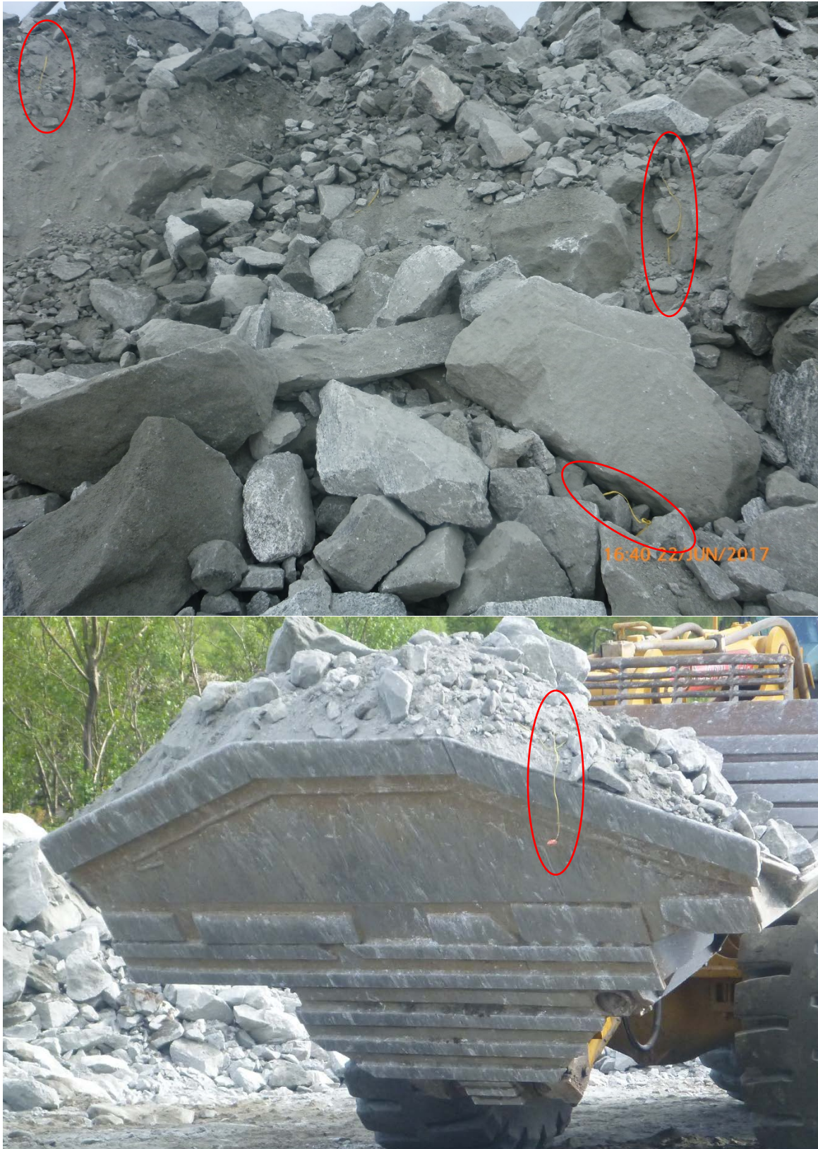
Figur 7: Rester av skyteledning i tunnelmasser
