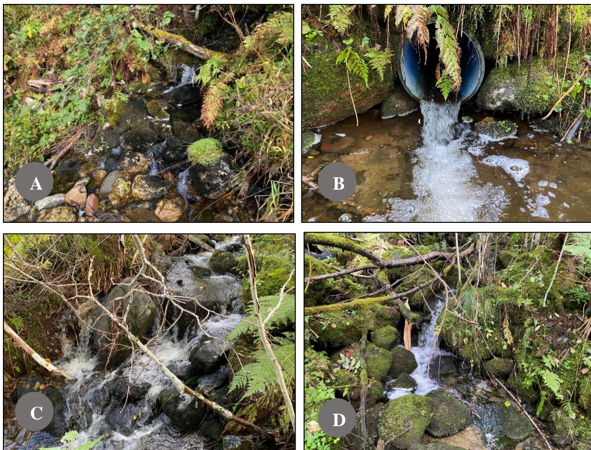
Figur 25. Vandringshindre og bekkelukkinger i Djupedalsbekken. A) Temporært hinder i segment 1. B) Rør i segment A1 er tørrlagt på oppsiden og utgjør et kunstig, absolutt hinder. C) Temporært hinder i segment 3. D) Øverst i segment 9 blir bekken både mindre og brattere slik at det anses som absolutt vandringshinder.
