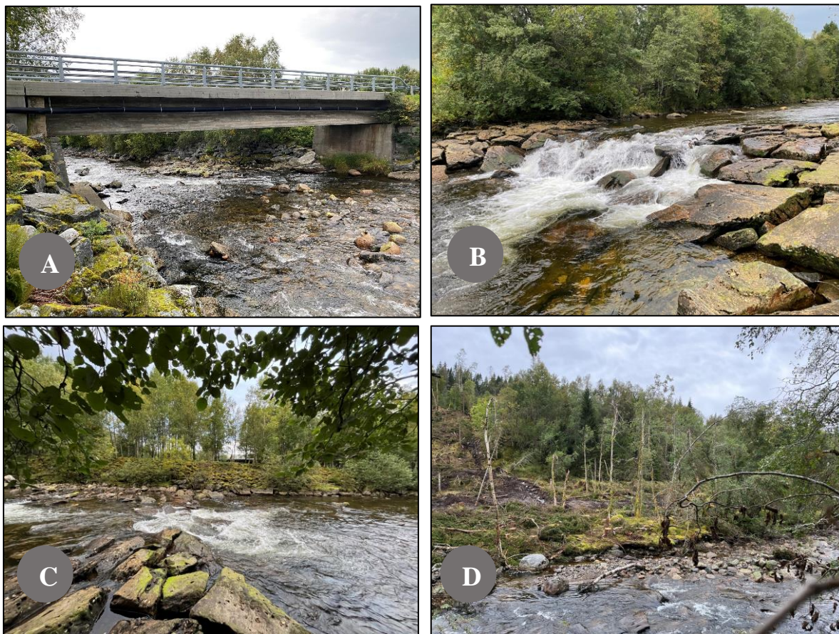
Figur 5. Bilder av morfologiske inngrep i Mittetelva: A) Kulvert med naturlig bunnsstrat nederst i elven. B) Steinterskel i segment 1. C) Steinterskel og forbygning (steinvoll) mot vest i øvre del av segment 1. D) Mangelfull kantvegetasjon (hogstfelt) mot vest i segment 2.
