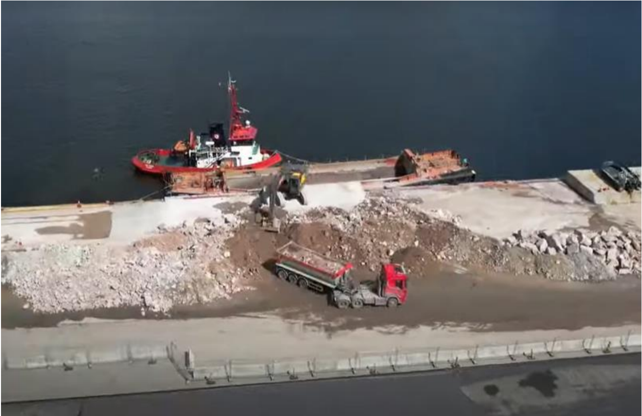
Figur 12: Splittlekter fylles via gravemaskin med stein tippet fra lastebiler 11
