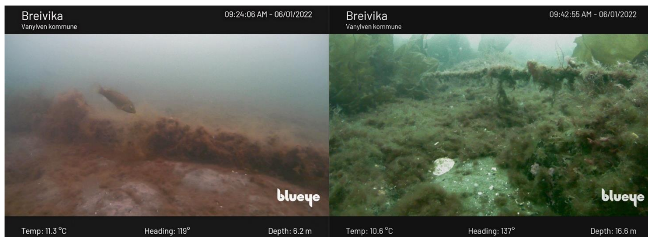
Figur 4: Til venstre: begrodd rør ved B1-1. Til høyre: begrodd kabel (se pil).
