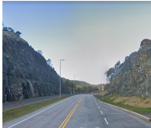
Figur 7: Situasjon Fylkesveg 5156 Lyseklostervegen
