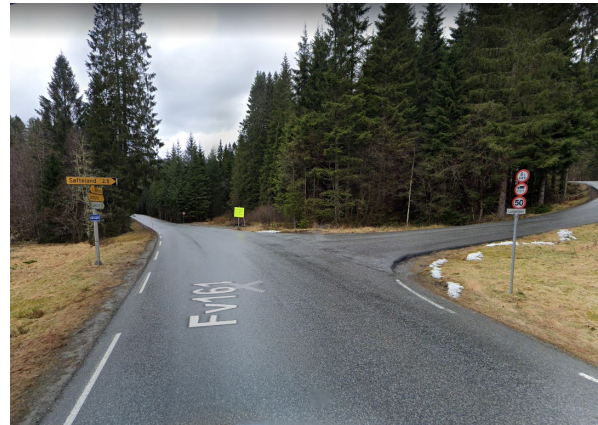
Figur 9: Situasjon kryss Lyseklostervegen x Langedalen
