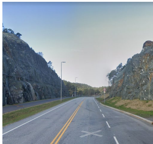
Figur 26: Situasjon Fylkesveg 5156 Lyseklostervegen
