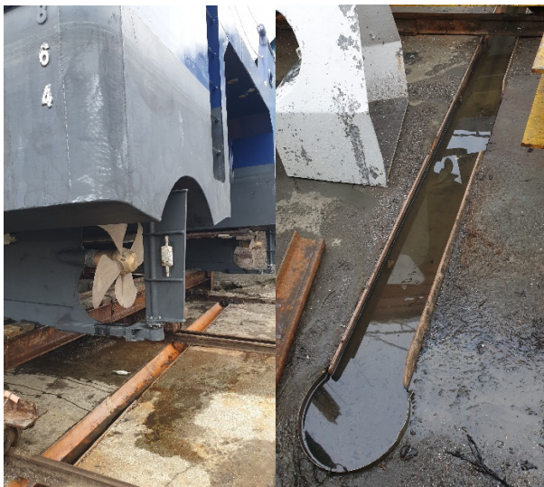
Figur 1. Renne for oppsamling av spylevann. (Båten på bildet kunne trekkes lenger opp, men den skulle ikke spyles.) (foto: Statsforvalteren i Nordland).
