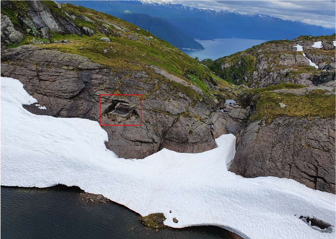
Figur 2-12: Betongkonstruksjon i forbindelse lukesjakt. Bildet er fra tjernet nedstrøms dammene.
