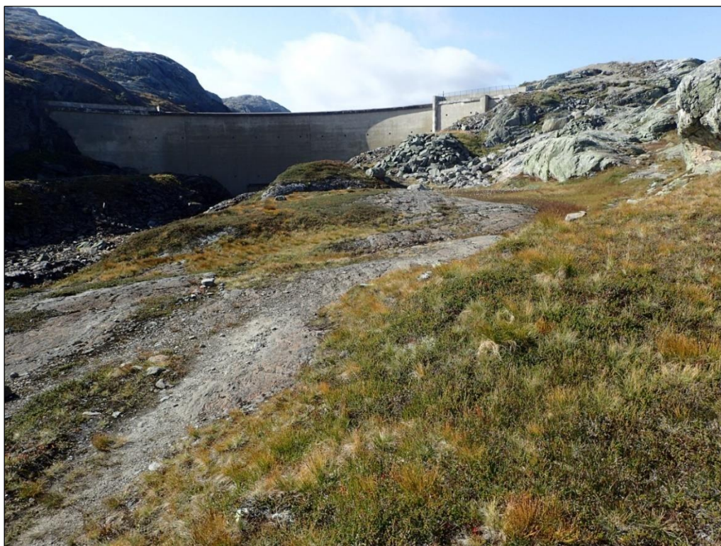
Bilde 2: Bilde av eksisterende dam ved Bjølsgrøvvatnet som skal rives. Ny dam skal bygges like nedenfor, nærmere kamera. Deler av steinrøys fra anleggsarbeidet på 1930-tallet synes til venstre og midt i bildet. Sperredammen synes ikke på bildet.
