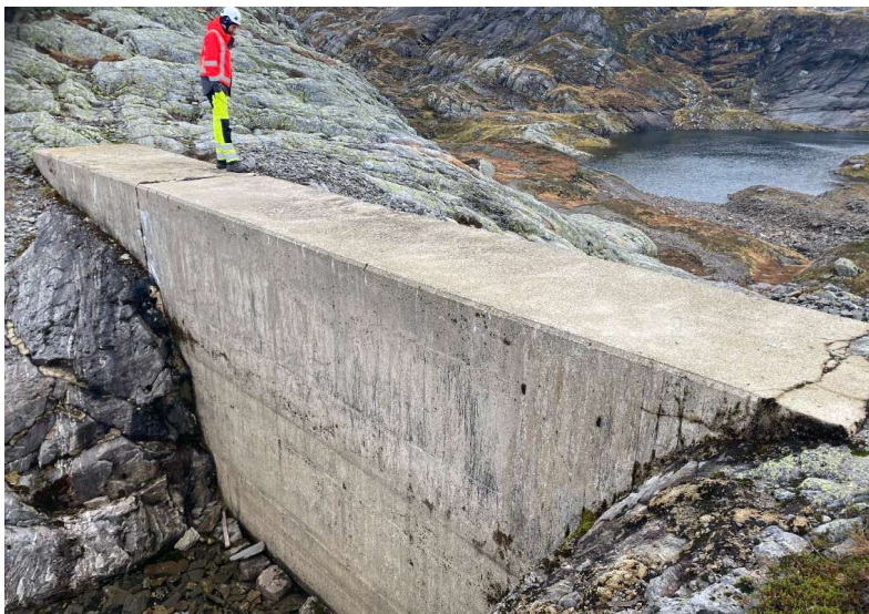
Figur 2-3: Dagens sperredam sett fra oppstrøms side. Oppe til høyre i bildet sees tjernet som ligger på nedstrøms side av damanlegget. November 2020.
