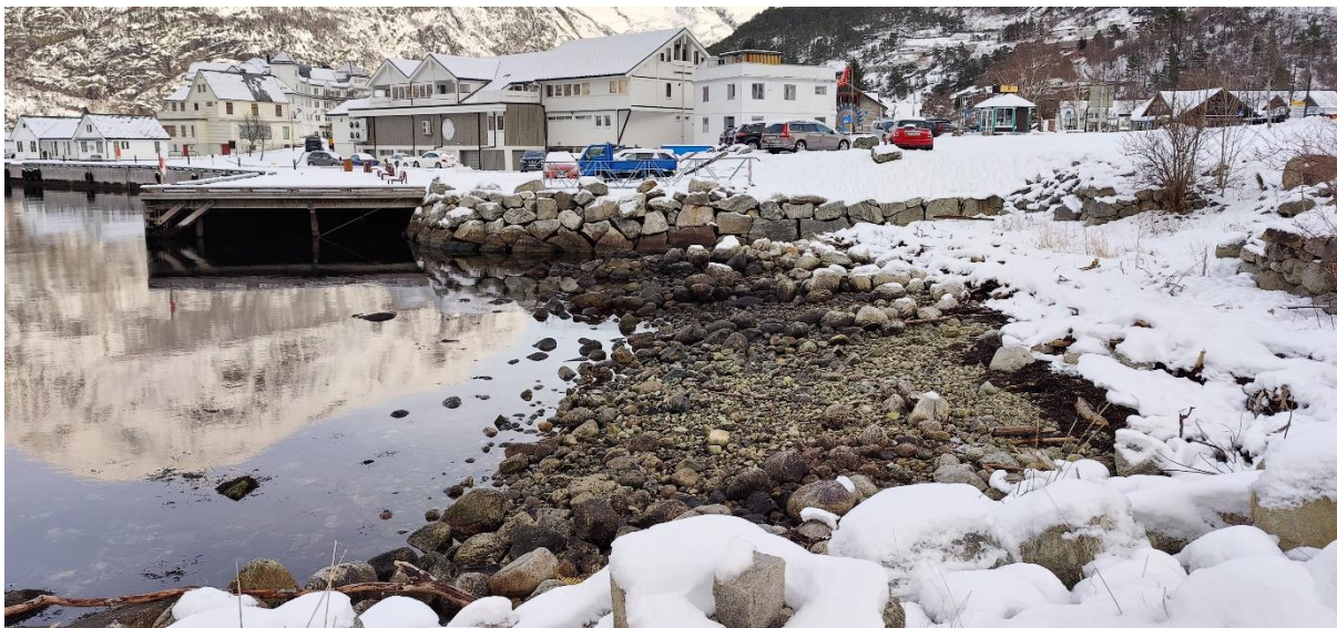
Fig. 3: Eksisterande rullesteinsstrand, plastring og pela trekai. Deler av stranda vert beheldt urørt.
