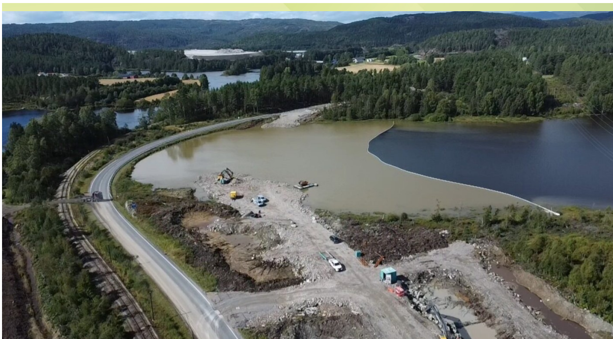
Gjerustadkilen 26.08.2024 like før anleggsarbeidet stanset.
