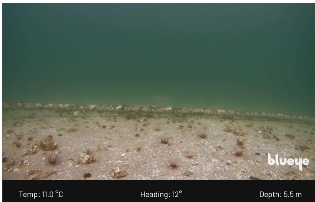
Figur 12. Vannledning i tiltaksområdet.
