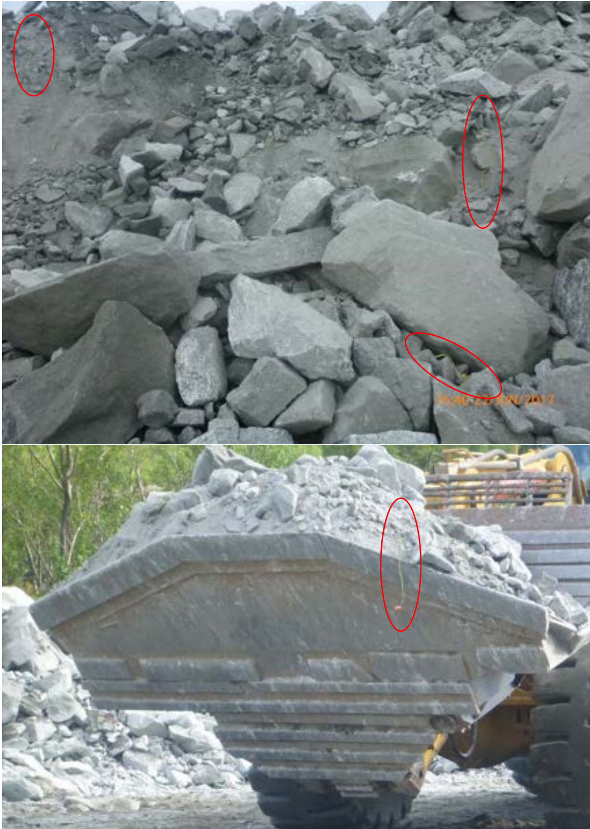
Figur 7: Rester av skyteledning i tunneltmasser
