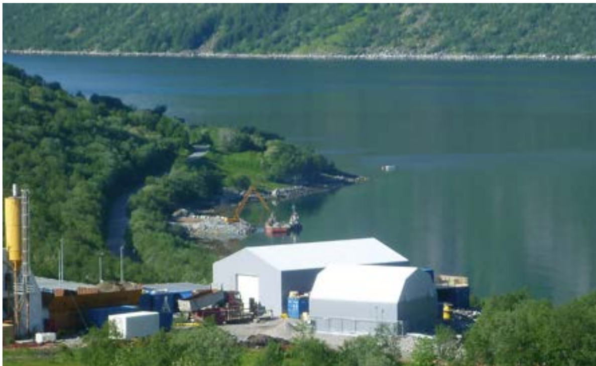
Figur 8: opplasting av tunnelmasser fra testsalve i Aldersundet
