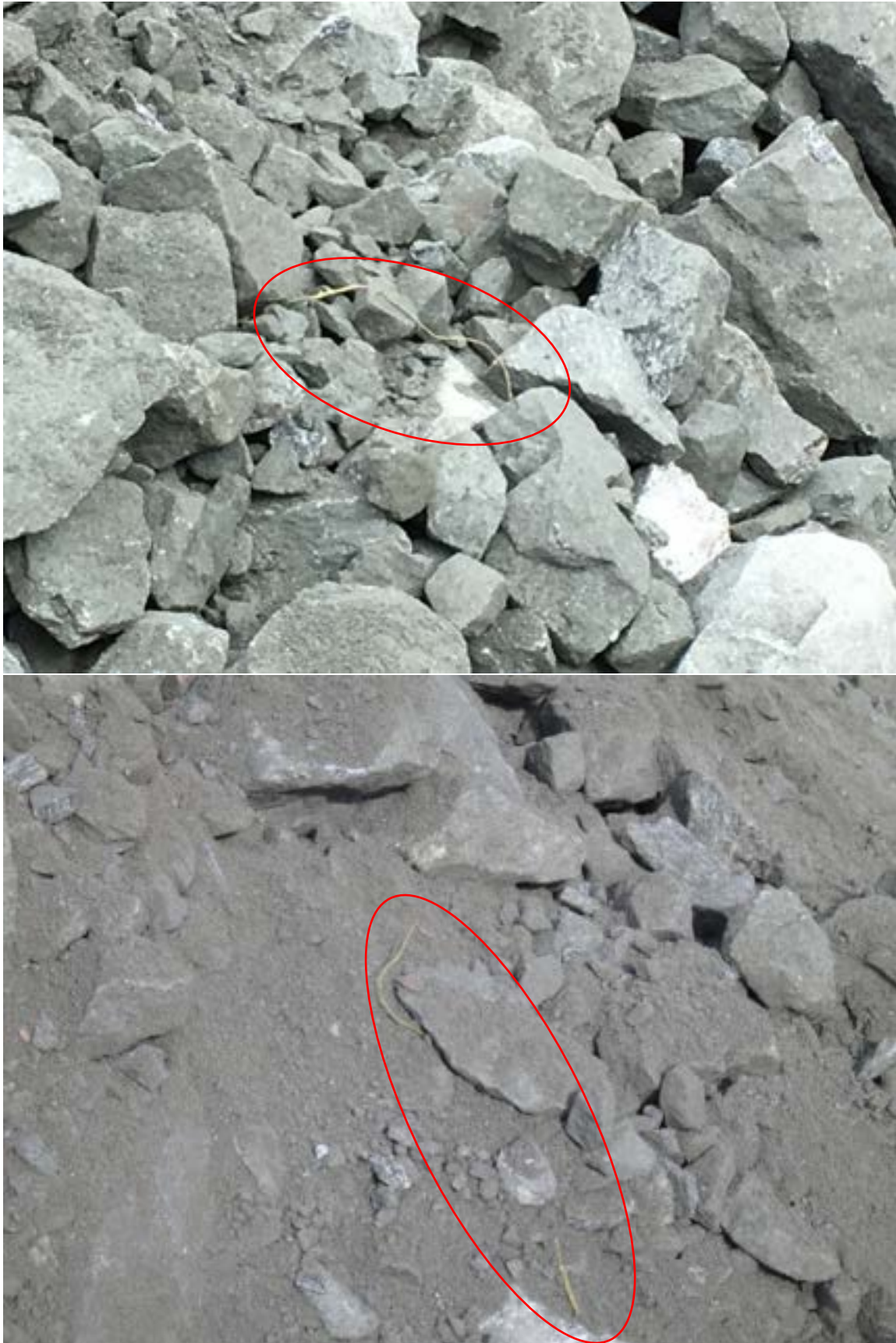
Figur 10: Rester av skyteledning i opplastede masser på lekter
