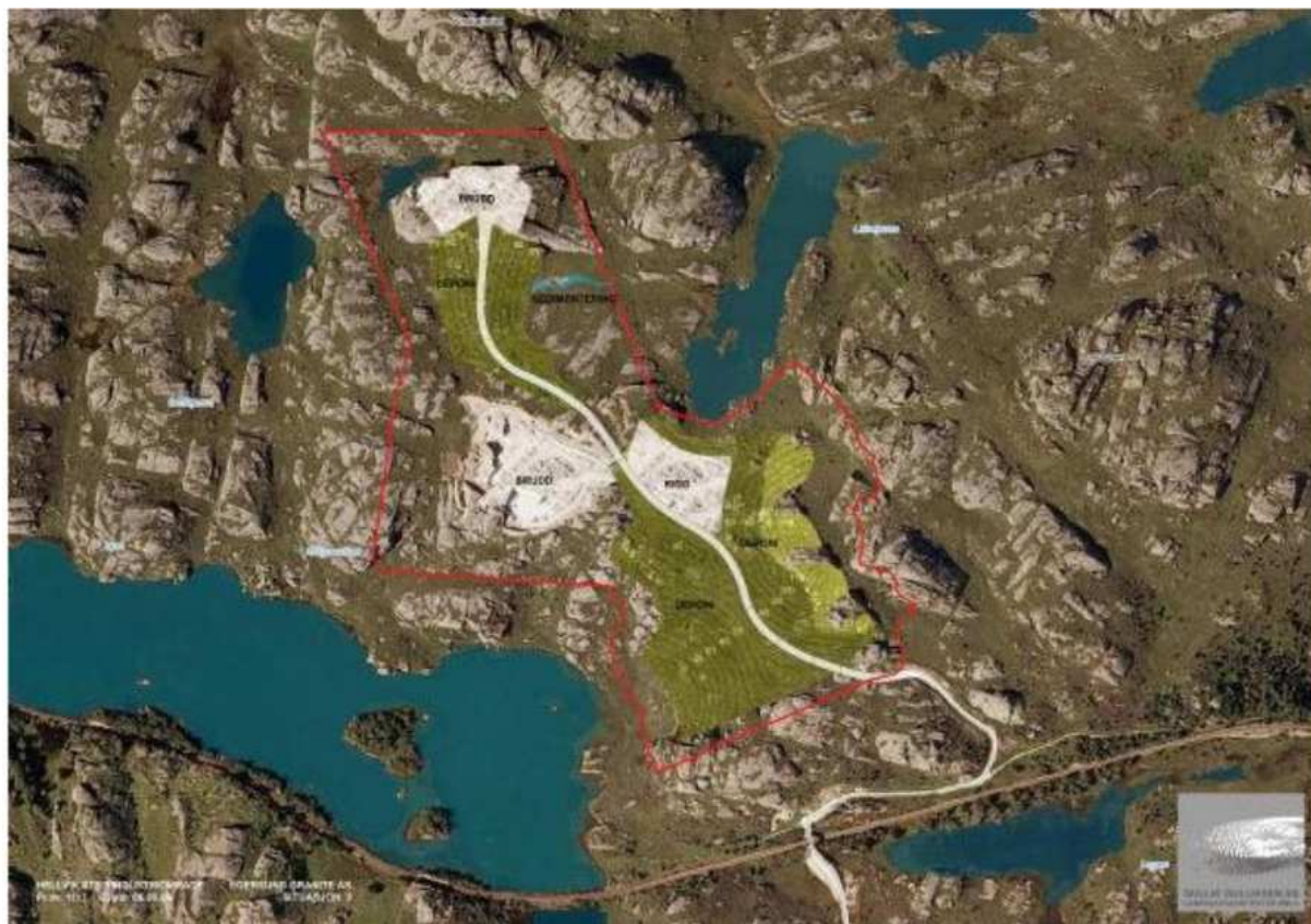
Figur 4.6b Oversikt deponi montert i ortofoto
