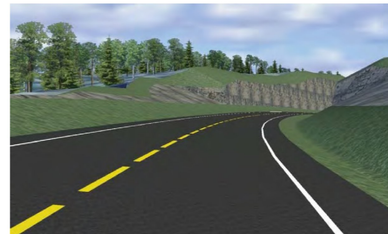
Figur 49: Avrunding i enden av bratt fjellskjæring ca. ved profil 7500
