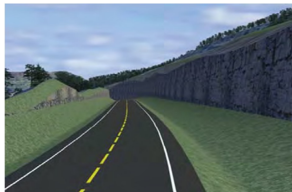
Figur 52: Ny veglinje gjennom tosidige skjæringer sett østover mot Klokkergården ved pel 9000
